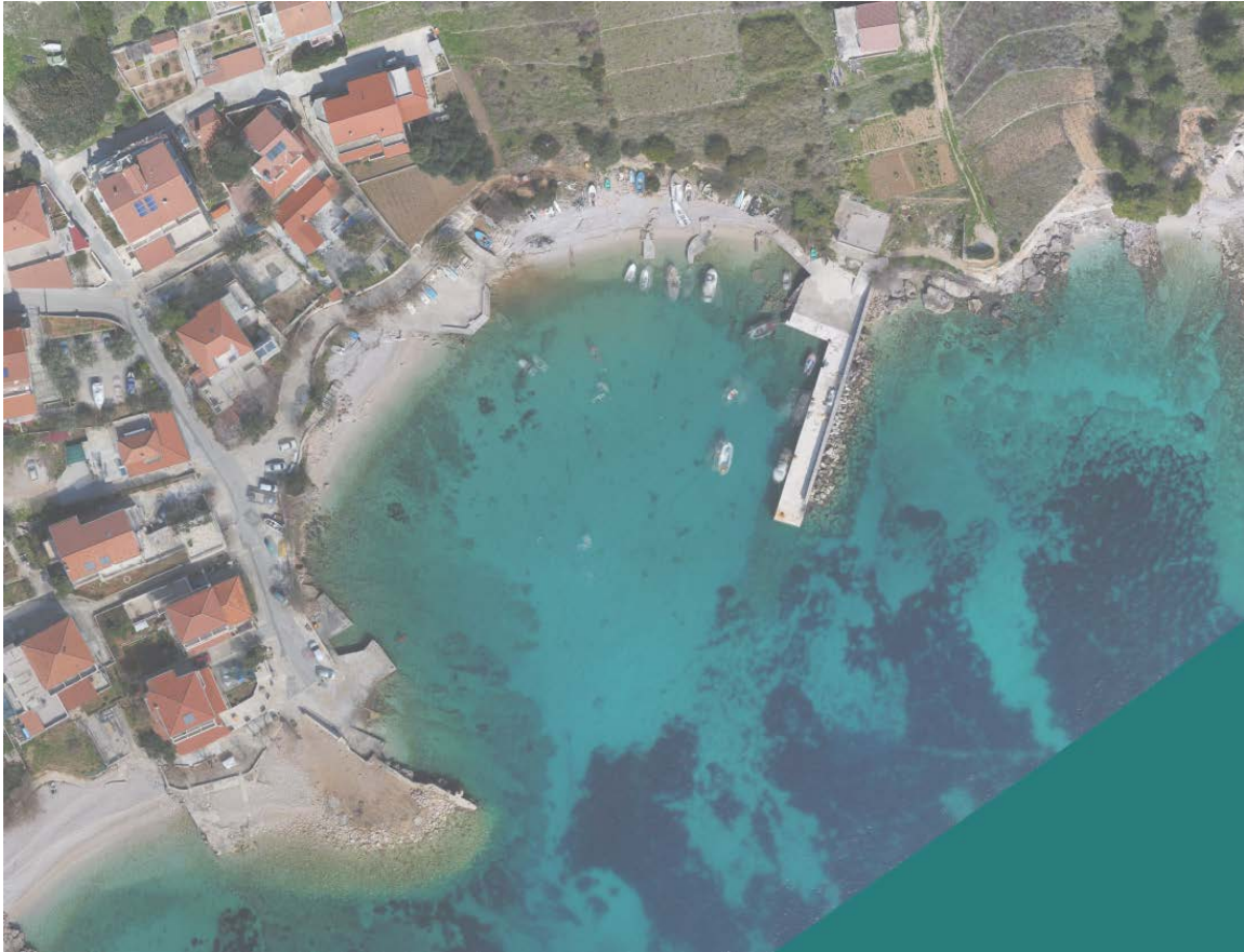
Prilog br. 7 luka Zavala- postojeće stanje
